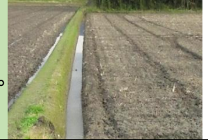
図1 周囲溝の施工
