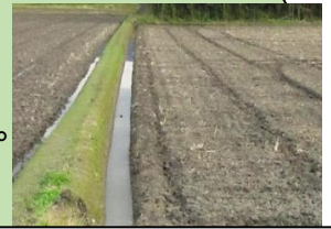
図1 周囲溝の施工
